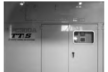
土山工場内の排ガスを利用して発電するガスタービン
